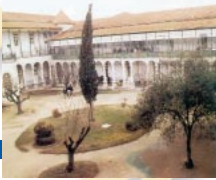
O velho edifício de S. Jerónimo onde funcionavam os HUC
